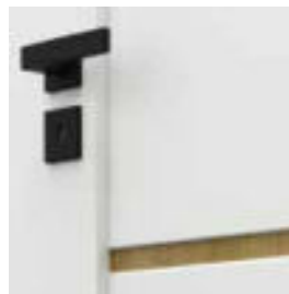
G0 modell - Dekoratív lemez (Portaperfect fólia), az ajtólap felületéhez viszonyítva süllyesztve. Függetlenes ereszettel opcionális - felár ellenében.
