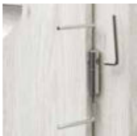
az állítható 3D pántok beállítása
